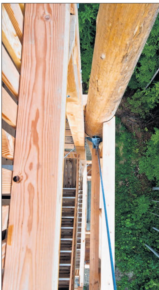
Blick in die Tiefe mit der Holzkonstruktion
